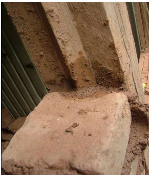
Ukázka tzv. kluzného napojení nepálené cihly na dřevěný sloupek. Na sloupku je uchycena dřevěná lišta ve tvaru trojúhelníku, která zasahuje do hliněné cihly.
